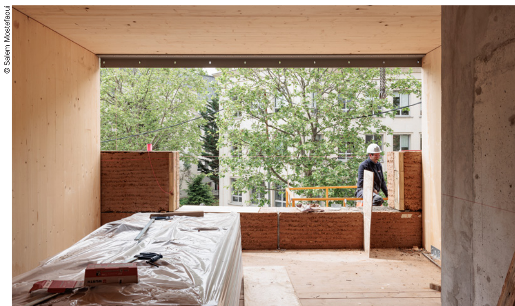
■ Les blocs sont assemblés après dimensionnage et séchage en atelier.
