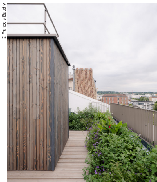
■ La toiture est végétalisée.
