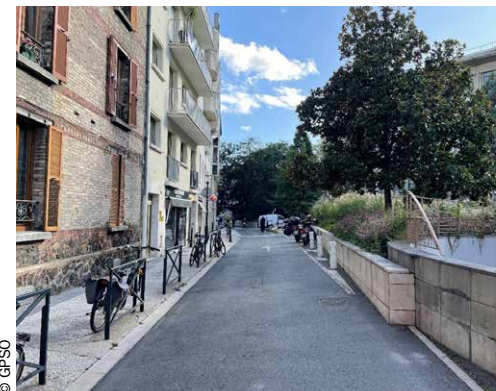
■ Rue de la Saussière avant et après travaux.
