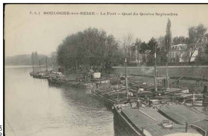
Le quai du 4-Septembre connaîtra la terrible crue de 1910. Les belles propriétés ont les pieds dans l'eau...
