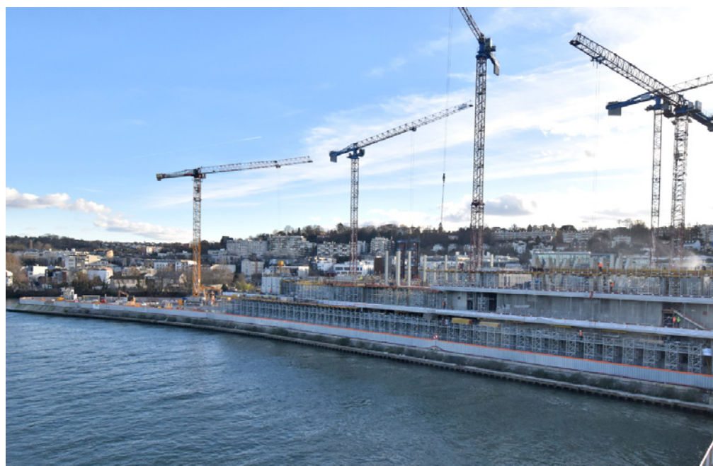
■ La Pointe des arts île Seguin en pleine construction. Vue depuis le pont Daydé.
